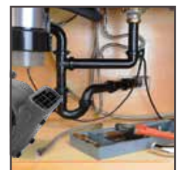
作業困難な場所にも 使用が可能
